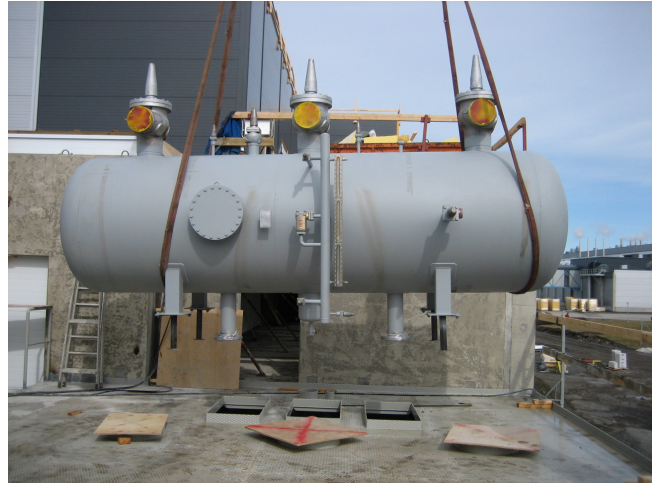
Logistiikkakeskus asennusvaiheessa vuonna 2006, kylmälaitoksen nesteenerotin / pumppusäiliö
