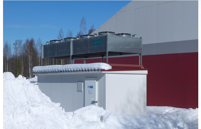
Eristetty kylmäkonehuonekontti (6,8 x 2,5m H=2,4m)
